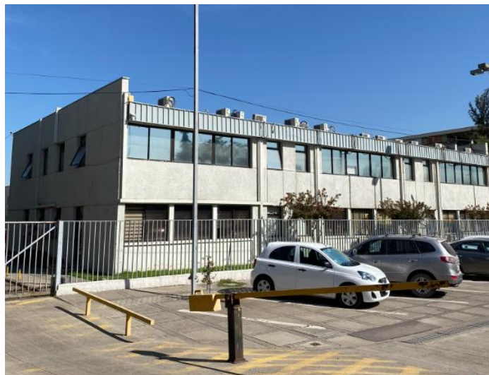
Ilustración 10 Registro fotográficos del sistema de climatización FCTEC
